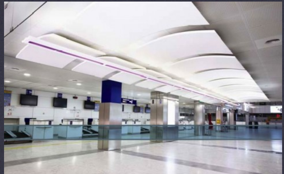
Paneles acústicos en el Aeropuerto de Niza
